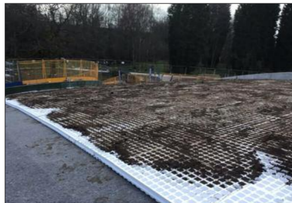
Herzstück des Gründachs ist das 75 mm hohe Bauder Green WSP für intensive Dachbegrünung.
