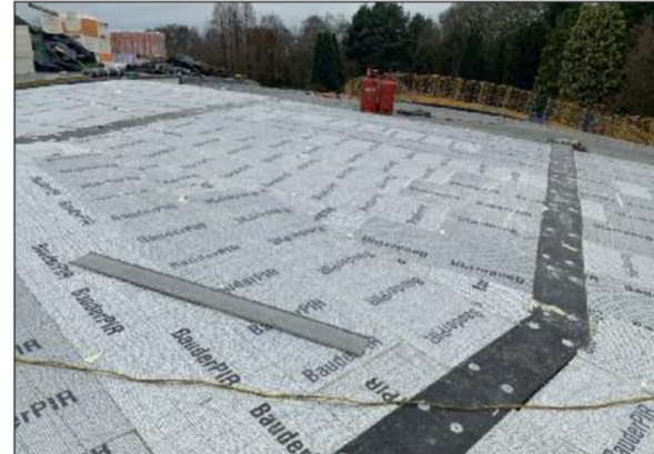
Verlegte Wärmedämmung aus BauderPIR.
