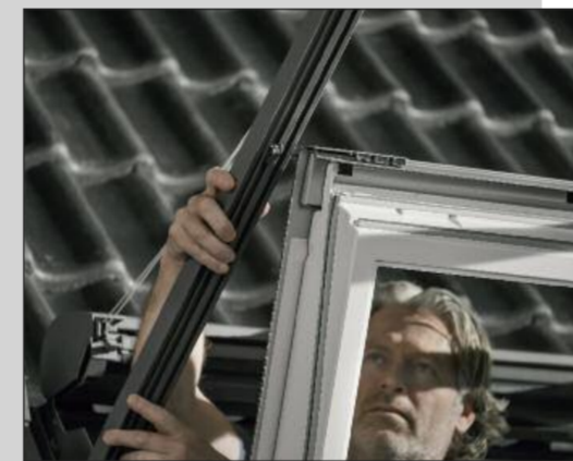
Für Effizienzsteigerungen beim Einbau des neuen Rollladens sorgen beispielsweise Klick-on-Lösungen: Sie reduzieren Einbauschritte und gewährleisten eine schnelle sowie sichere Montage von innen.
